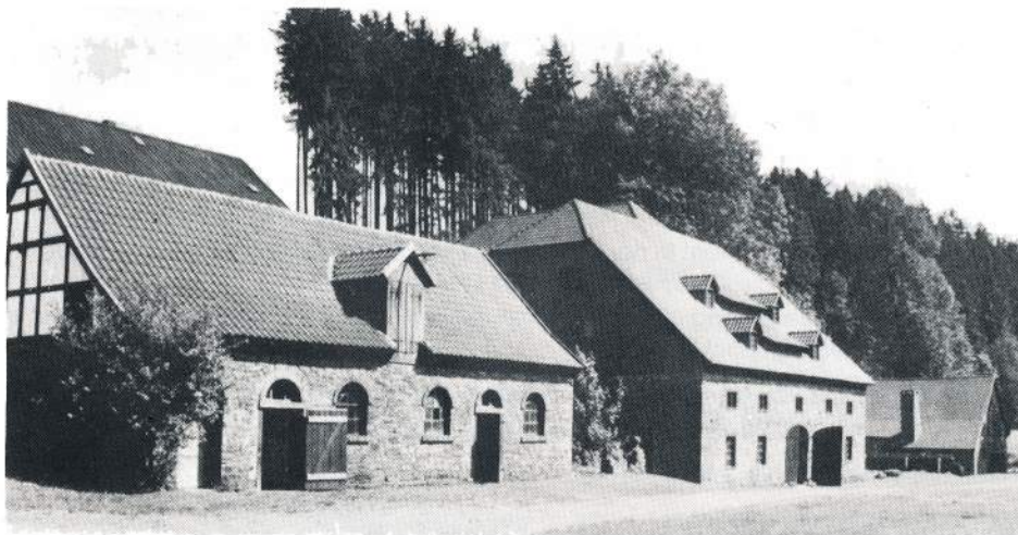
Die „Wendener Hütte“, Kulturdenkmal der Technikgeschichte, mit dem ältesten erhaltenen Hochofen Mitteleuropas
